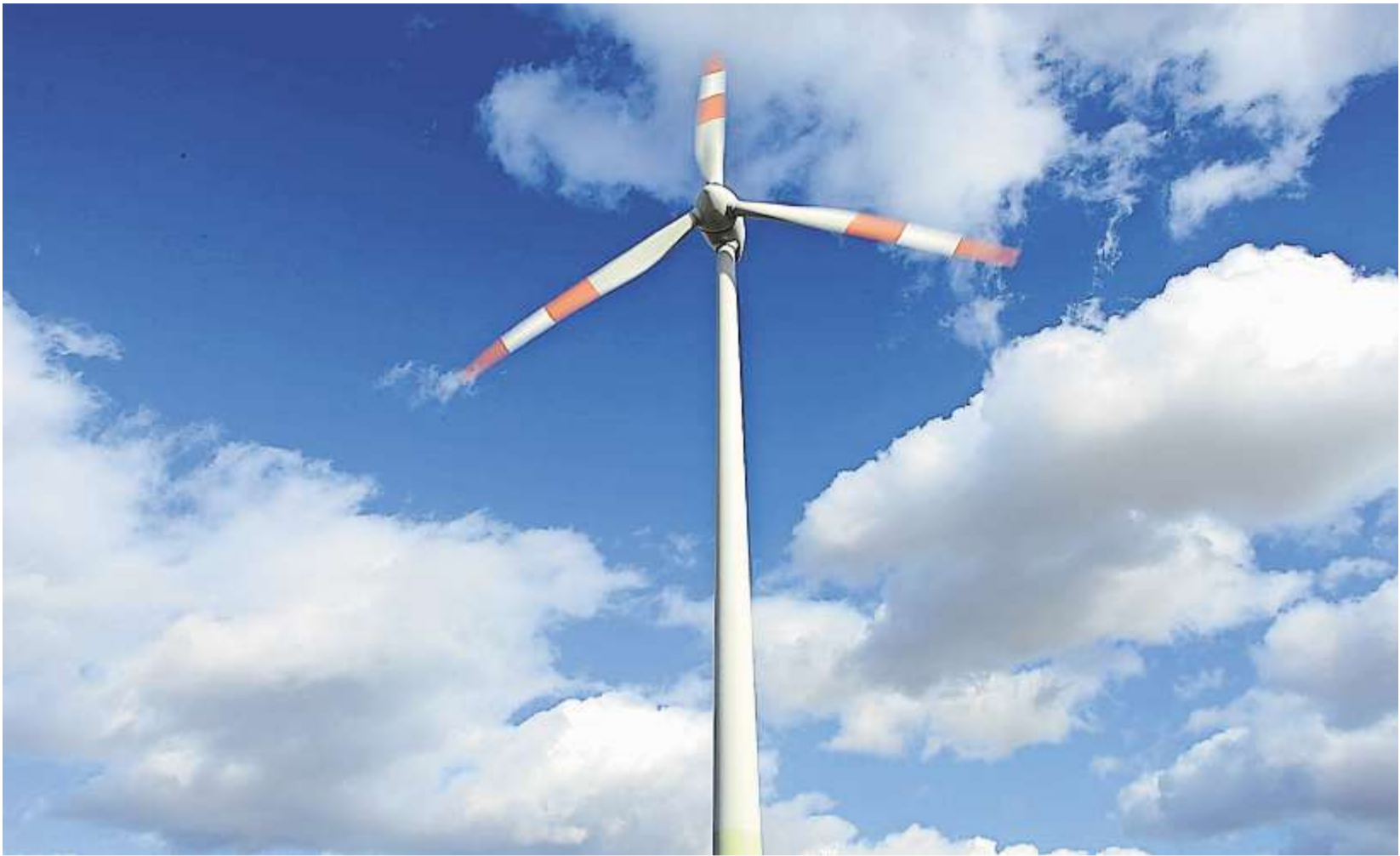
3100 Quadratmeter Bodenfläche braucht ein einzelnes Windrad, rechnet der Vertreter von Ostwind vor.
